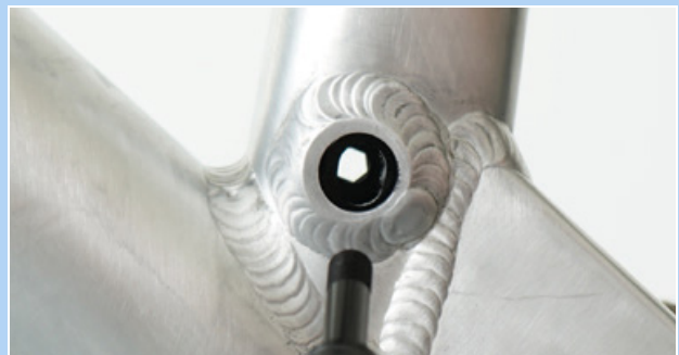
Afbeelding 192: Gat van de postpin-interface
